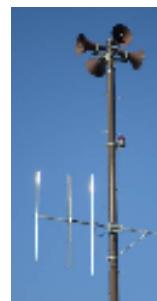
津波情報伝達システム (屋外拡声装置) 震災前50基⇒76基
