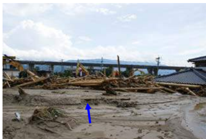
国道橋梁上流側から: 大量の土砂と流木の堆積
