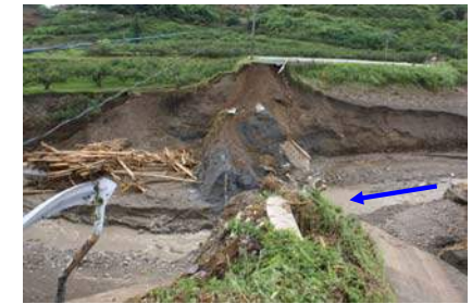
溜池堤体右岸側断面
