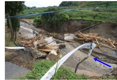
溜池堤体左岸と下流
