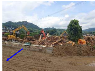
国道橋梁上流側の流木集積
