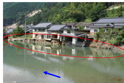
ダム湖右岸側(上流側から): 道路が護岸ごと流出している
