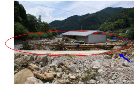
天然ダム堤体下流: 長さ22.3mの流木。ほぼ立木のままの状態。
