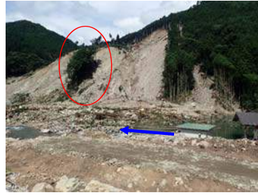
大規模斜面崩壊地(上流側から) 推定崩壊土量: 20.6万m 3
