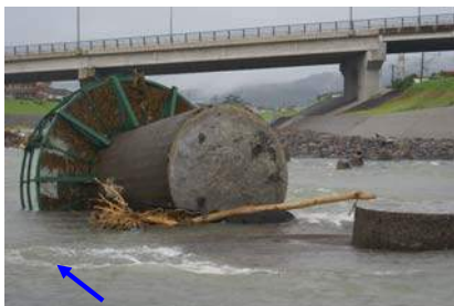
右から3番目の橋脚
