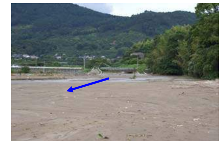
北川上流の土砂堆積状況
