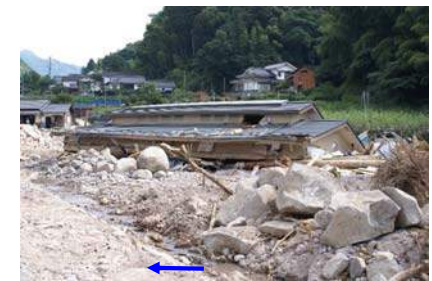
天然ダム堤体下流: 家屋の倒壊。
