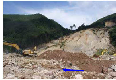
土砂と流木の撤去を行い、河道の維持を図っている
