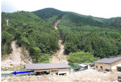
大規模崩壊地上流側の斜面崩壊
