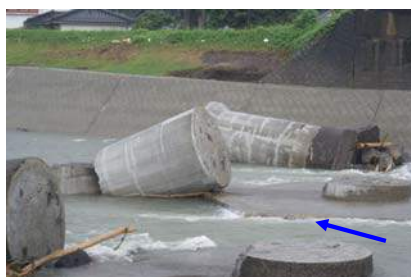
右から1, 2番目の橋脚
