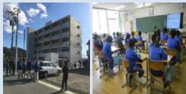
新たに完成した 災害公営住宅
