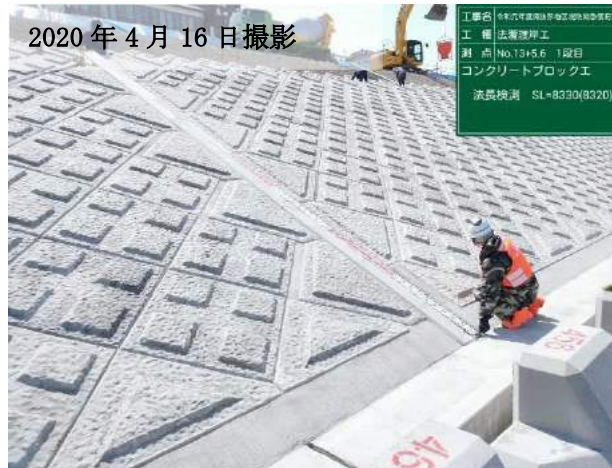
大型ブロック張の施工完了状況写真
