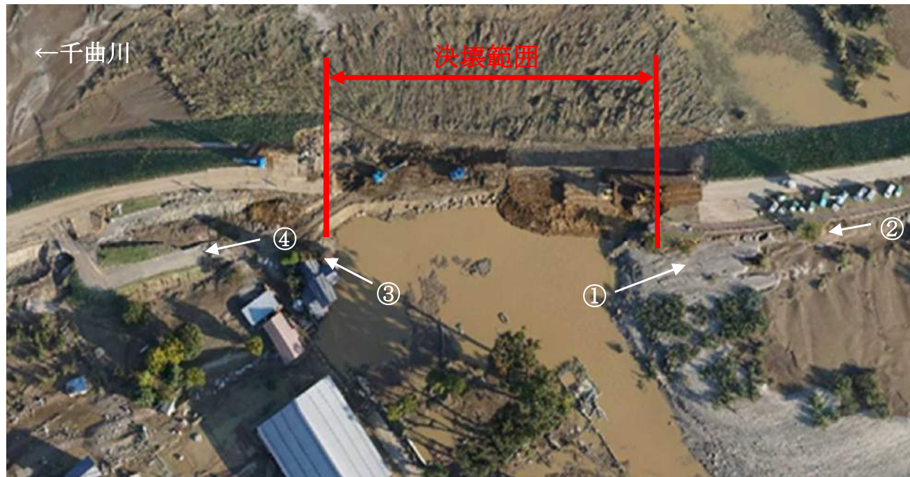
堤防破堤状況
