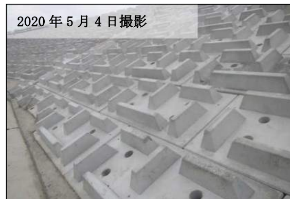
裏法の被覆状況 (大型連節ブロック)
