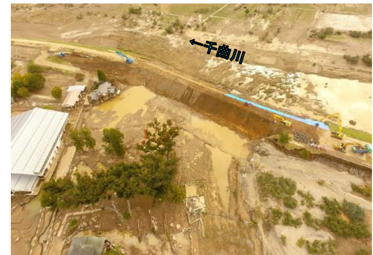
測量時空撮・仮堤防完成時 (2019. 10. 18撮影)
