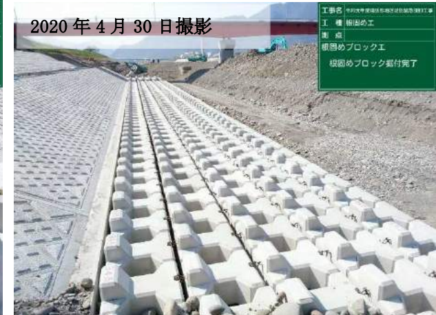
根固めブロックの施工完了写真
