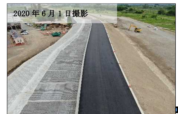
堤防復旧状況
