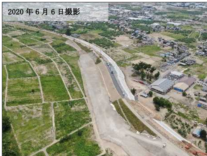
堤防復旧状況
